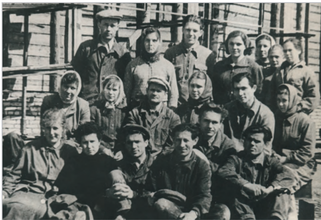
Бригада А. Г. Лёвина на работах по реконструкции здания Рижского вокзала в годы восстановления народного хозяйства после Великой Отечественной войны
