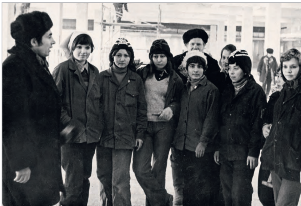
На строительстве Волжского автомобильного завода
