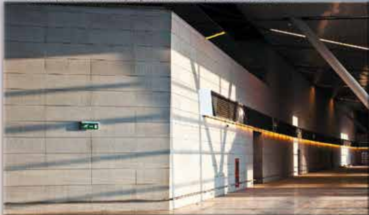
▲ Общественная зона. Устройство полов и внутренних фасадов из натурального камня, устройство реечных потолков
