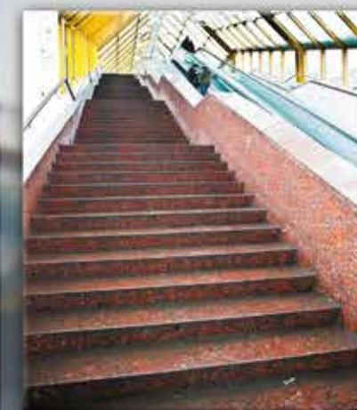
▲ Киевский пешеходный мост. ▼ Наружная и внутренняя облицовка мостовых конструкций
