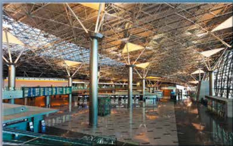
▲ Зал регистрации. Устройство полов из натурального камня, облицовка колонн, устройство плафонов освещения
