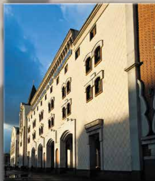
▲ Управление Московской Железной дороги. Облицовка первого этажа из натурального камня
