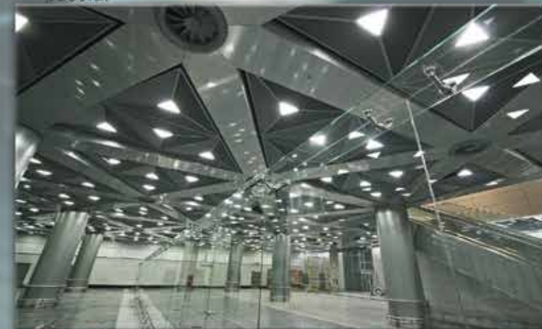
▲ Зал досмотра пассажиров электропоезда. Устройство полов из натурального камня, облицовка колонн и потолков
