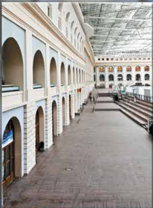
▲ Архитектурно-отделочные работы в Гостином Дворе. Отделка ▼ внутреннего фасада. Облицовка полов атриума природным камнем
