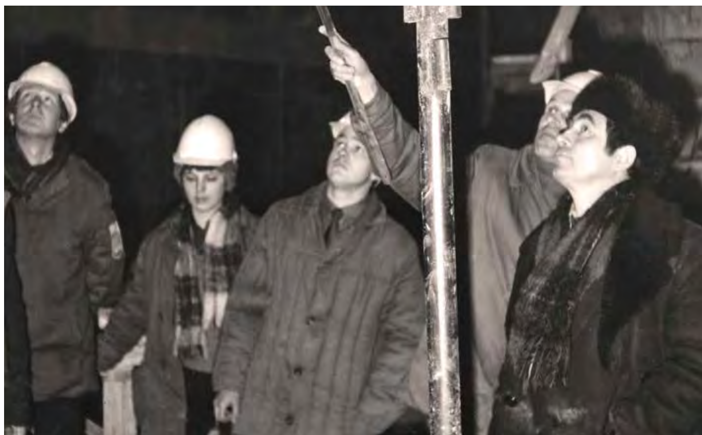
Рабочее совещание с бригадой на одном из строящихся объектов метрополитена
