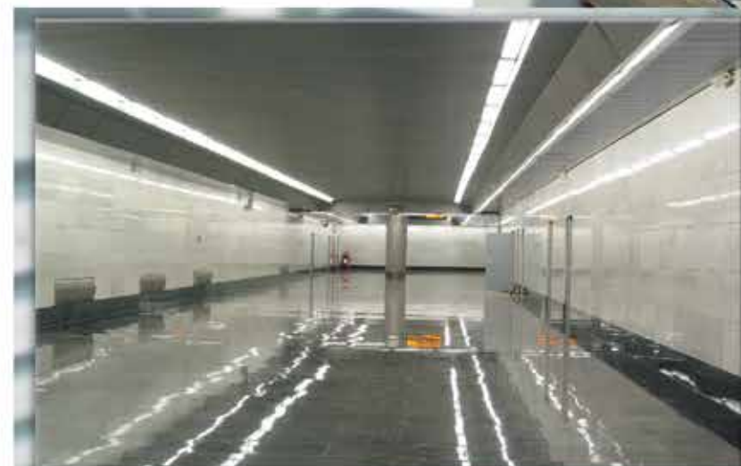
▲ Тоннельный участок со станционным комплексом Внуково. Пешеходный переход. Устройство полов, стен, потолков
