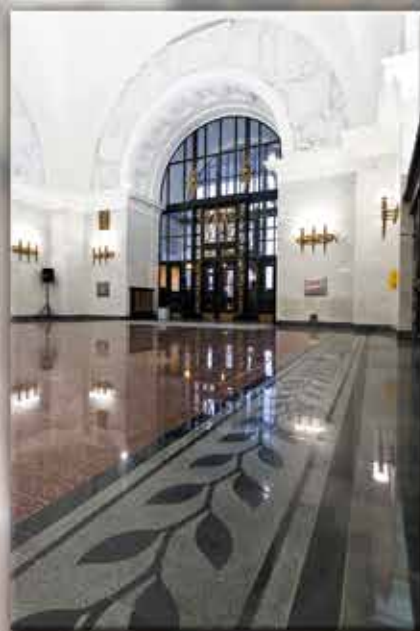
▲ Станция Октябрьская. Облицовка стен. ▼ Орнаментированный пол из натурального камня.
