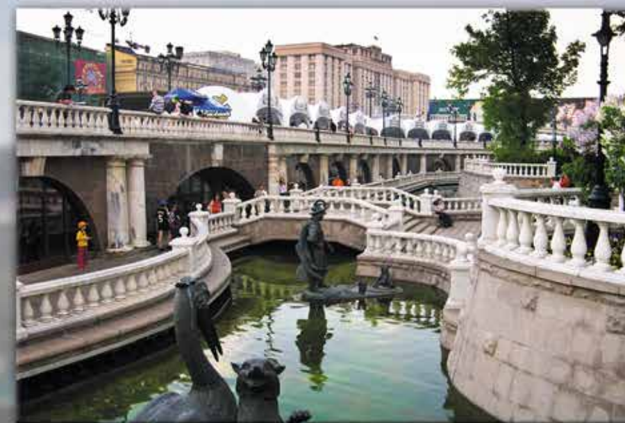
▲ Манежная площадь. Комплекс облицовочных работ
