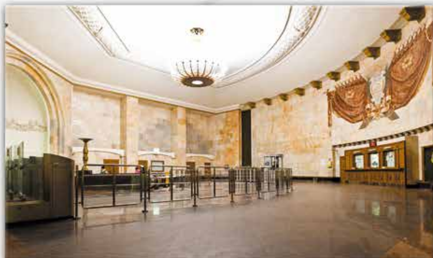
▲ Станция Площадь Революции. Облицовка стен и полов натуральным камнем.
