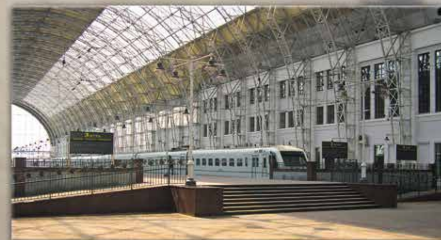
▲ Комплекс облицовочных работ на Киевском вокзале
