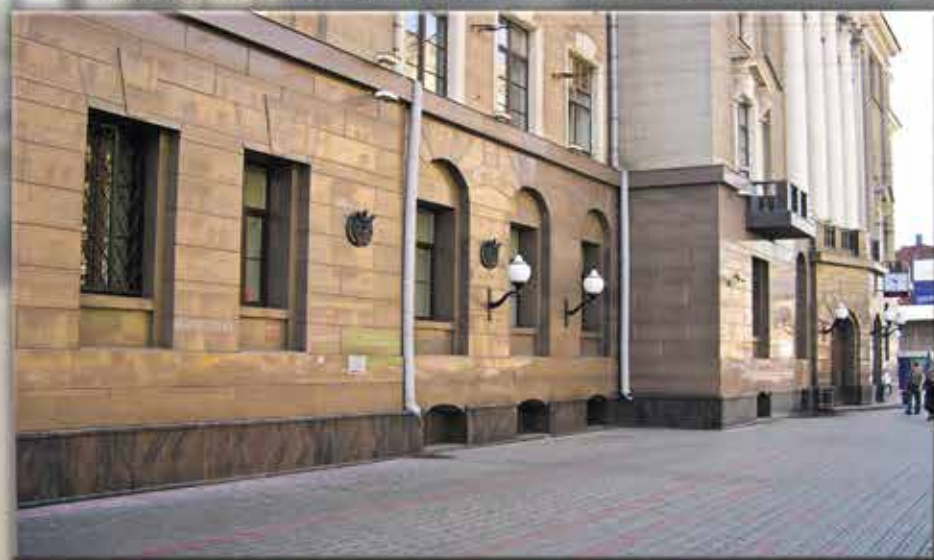
▲ Управление Московской Железной дороги. Облицовка первого этажа из натурального камня
