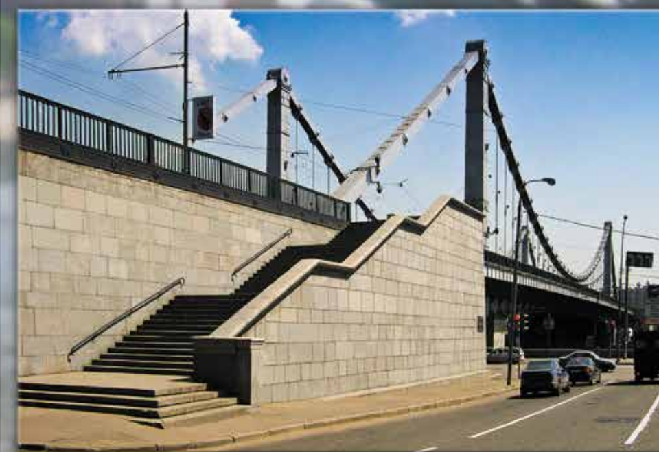
▲ Крымский мост. Облицовка лестниц и парапетных стен
