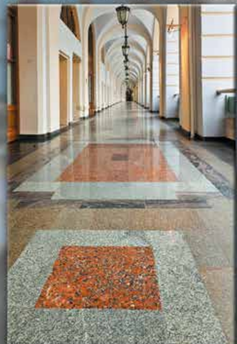
▲ Архитектурно-отделочные работы в Гостином Дворе. Отделка ▼ внутреннего фасада. Облицовка полов атриума природным камнем
