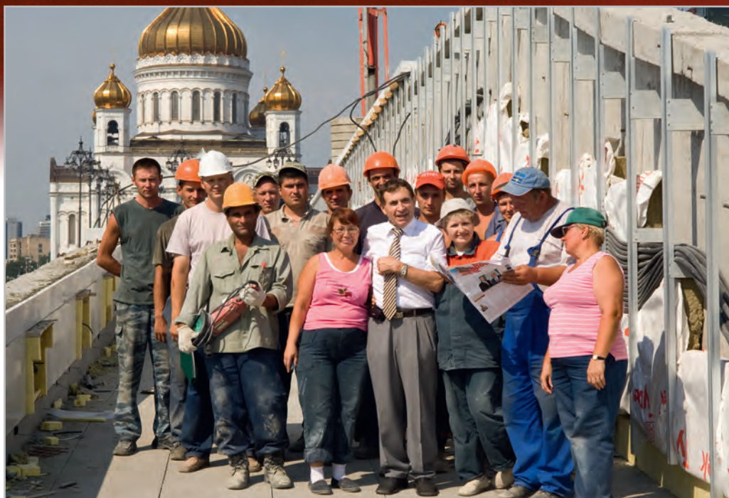
Герой Социалистического Труда А.Г. Лёвин с бригадой рабочих на строительстве Храма Христа Спасителя и Патриаршего Моста в г. Москве
