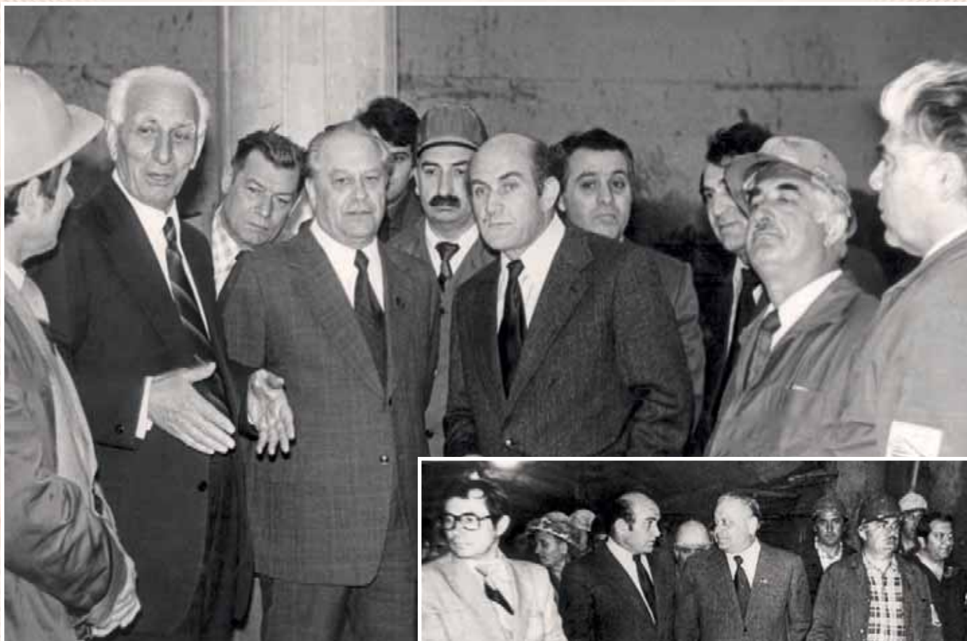
Рабочая встреча с премьер-министром Грузии, Министром транспортного строительства СССР И. Д. Сосновым, и Героем Социалистического Труда В. Д. Гоцеридзе на строительстве метрополитена в Тбилиси
